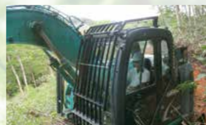
ユニックによる作業道開設作業
