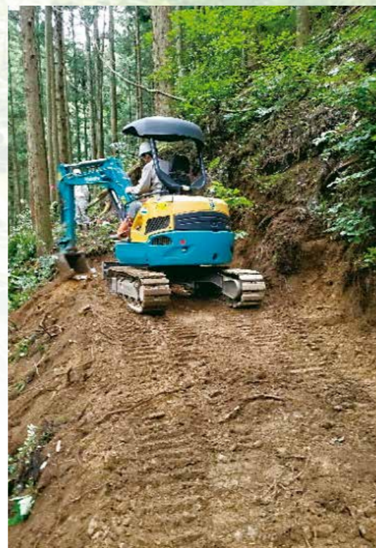
壊れない作業道の作設作業中
