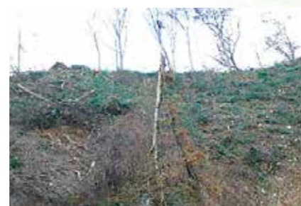
架線集材作業
