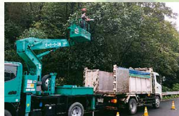
高所作業車による伐採
