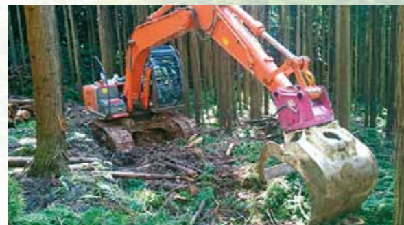
丸太運搬のための作業道を開設
