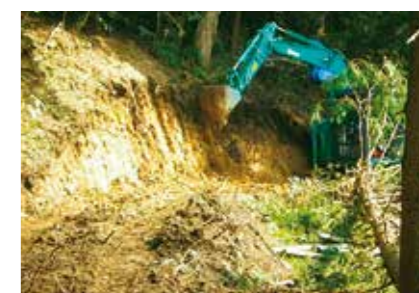
作業道開設作業
