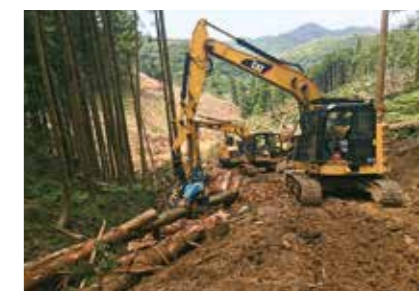
ハーベスタによる伐倒、造材作業
