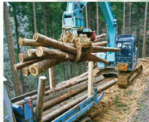
グラップルによる原木積込作業
