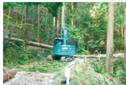
大径木の伐倒作業
