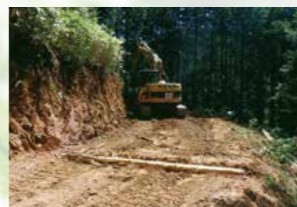
作業道開設作業
