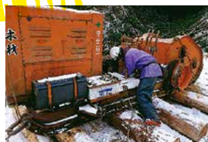
集材機の架設作業
