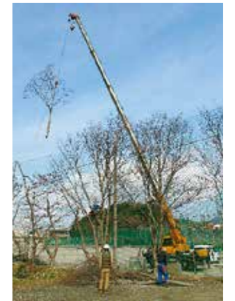
吊り伐りによる支障木の特殊伐採作業
