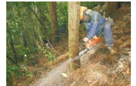
チェーンソーによる伐倒作業
