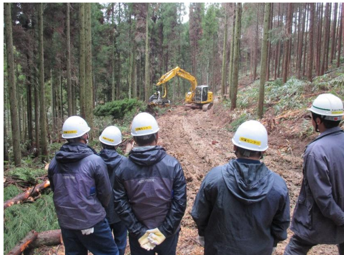
作業見学(ハーベスタによる枝払い)
