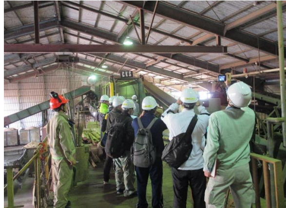
工場内のチップ生産機械(バーカー・チップパー)
