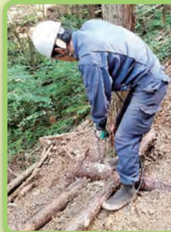
壊れにくい作業道に欠かせない丸太組工の施工作業
