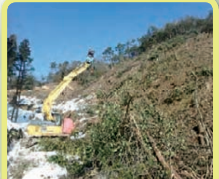
スイングヤードによる集材作業
