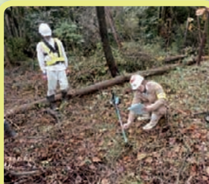
作業前の刈払い機点検
