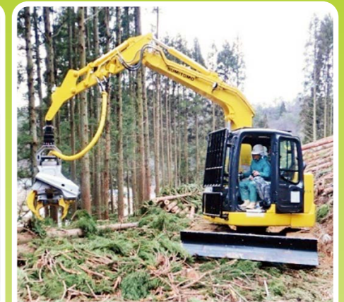
伐採・枝払い作業中
