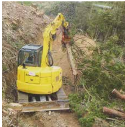
伐採作業現場
