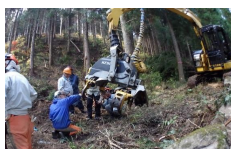
FW3:安全な素材生産作業の確認
