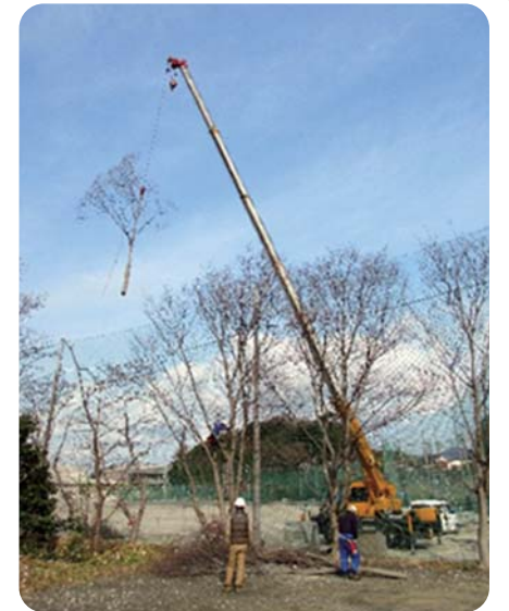
吊り伐りによる支障木の特殊伐採作業
