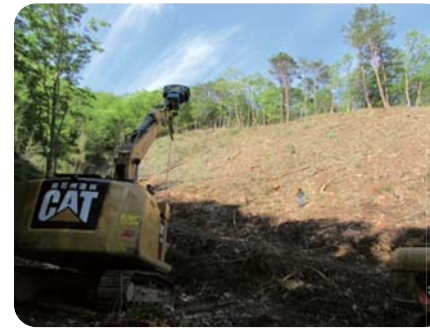
スイングヤードによる集材作業
