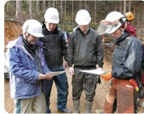
作業前のミーティング
